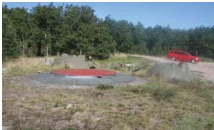
Pansarkupol, maskeringshuv och plåt över den tömda pjäsbrunnen
