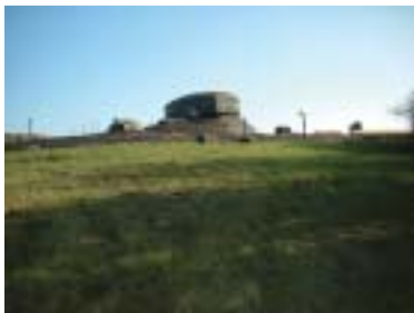
Västra Hästholmen, batteri H 1 2.pjäs och kommandoplatz batteri H2
