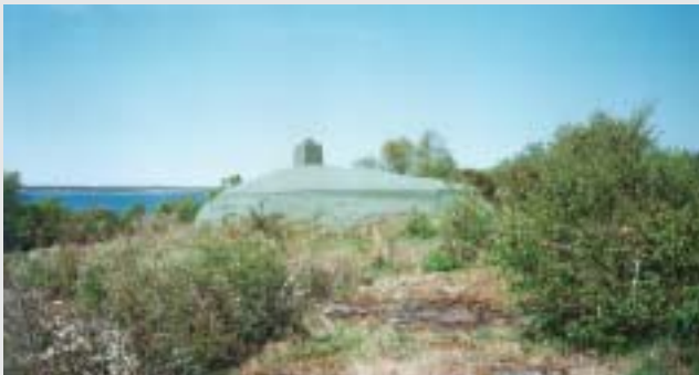
Minstation Östra Hästholmen
